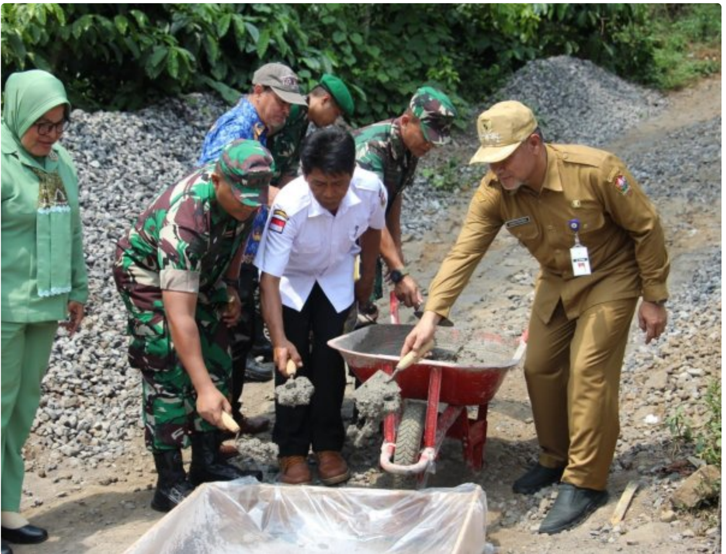
Simbolis Pengecoran Pertama Betonisasi
